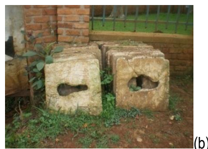
Stock de dalles défectueuses non utilisé
